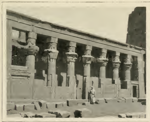
FIG. 432. — LA FAÇADE EST DU MAMMISI, A PHILÆ. (Cliché Fiorelli.)
